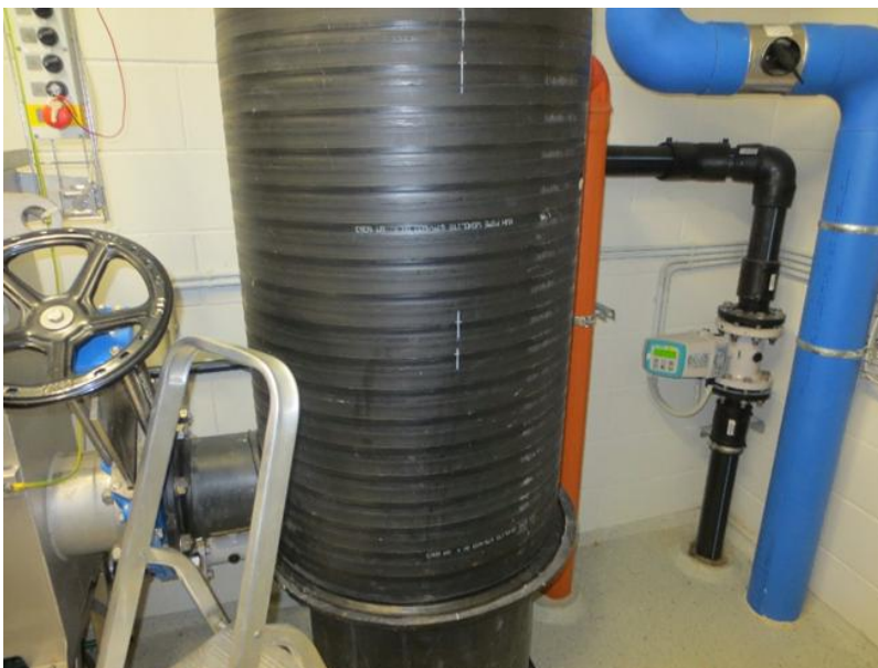
Joonis 5-10 Veltsi reoveepuhasti sisevaade. Vastuvõtumahuti
