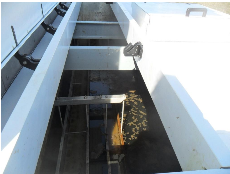
Joonis 5-20 Lasila RVP järelsetiti
