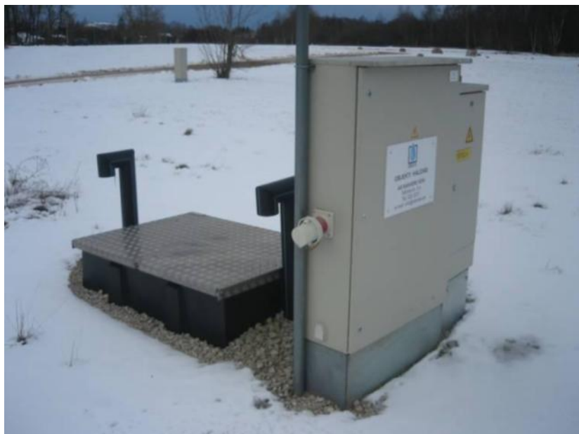
Joonis 5-1 Kompaktpumpla RP-1 kunagise Sõmeru reoveepuhasti territooriumil
