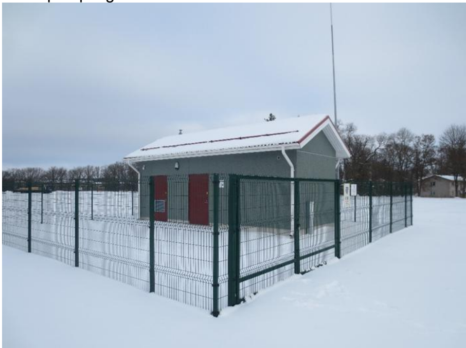
Joonis 4-5 Uhtna aleviku rekonstrueeritud asula puurkaevpumpla nr 3329 välisvaade (vasakpoolne uks avaneb generaatoriruumi)
