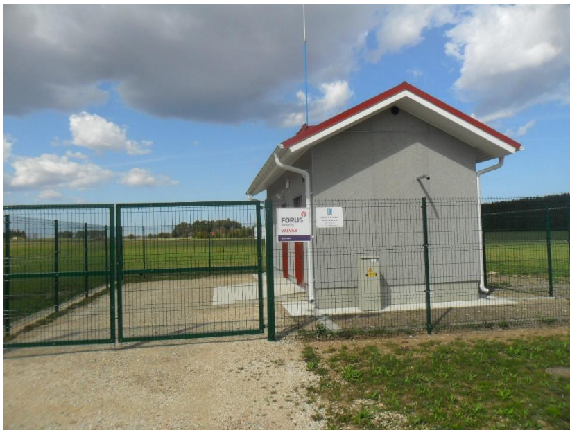
Joonis 4-17 Kohala uue puurkaevpumpla nr 63086 välisvaade
