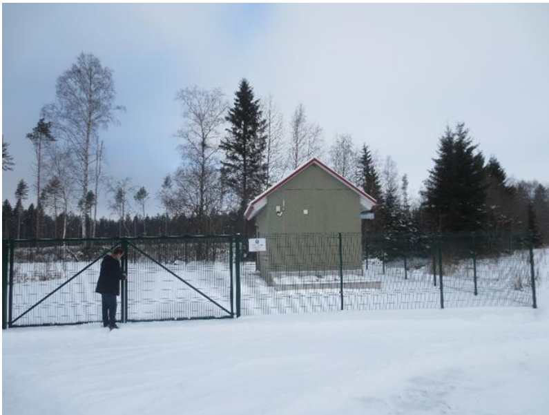
Joonis 5-9 Veltsi reoveepuhasti välisvaade
