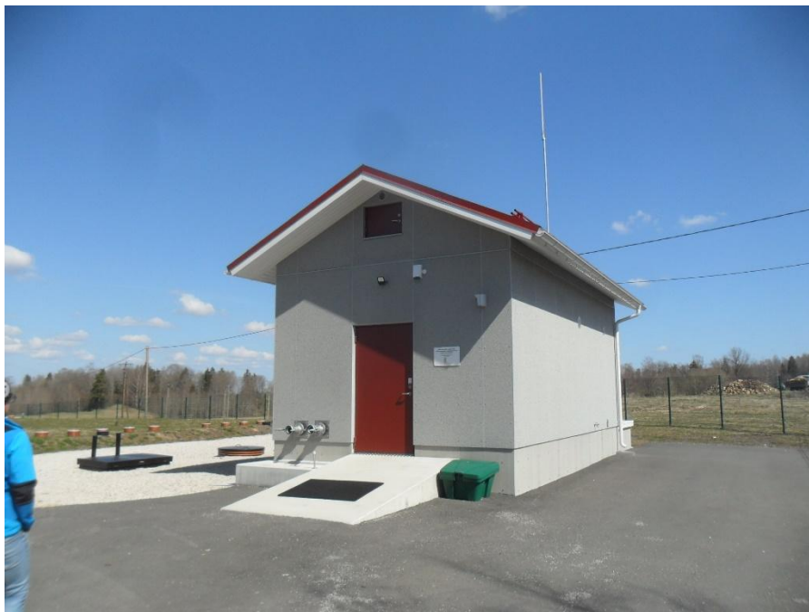
Joonis 5-19 Lasila uue reoveepuhasti välisilme
