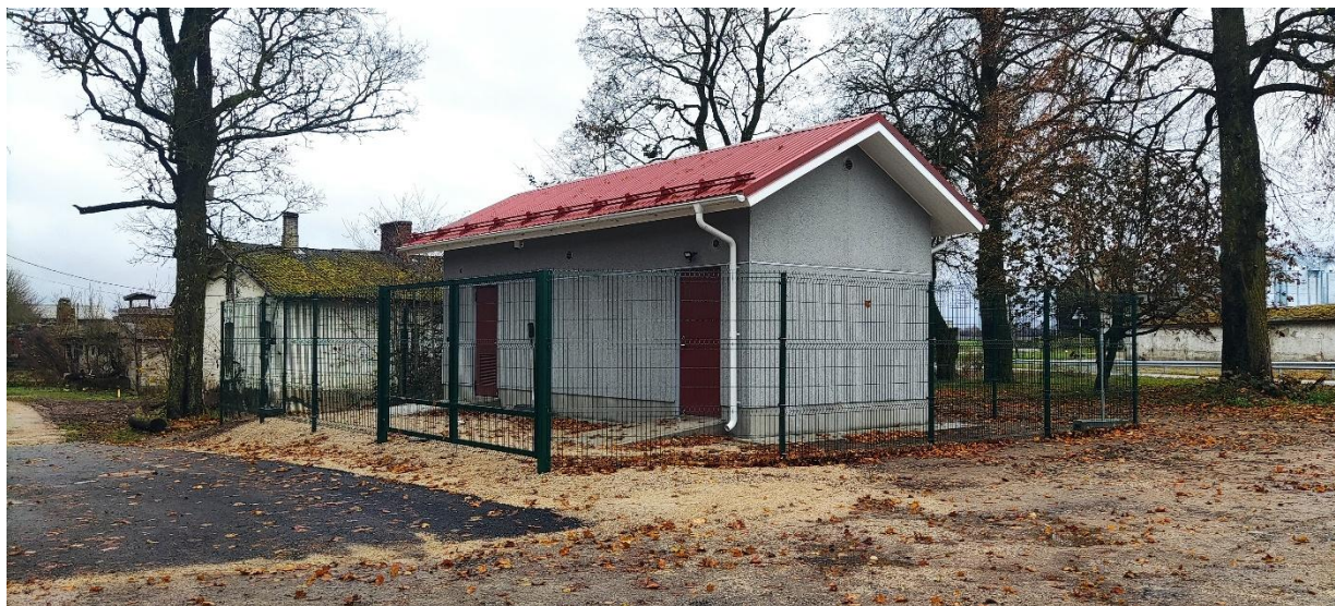
Joonis 4-12 Vaeküla Keskuse rekonstrueeritud pumpla välisvaade (pumpla rekonstrueeriti aastal 2023 ning anti käiku 2024)
