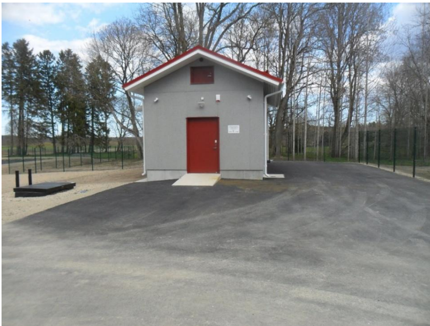
Joonis 5-17 Kohala reoveepuhasti välisvaade, tehnohoone ja reoveepumpla maapealne osa
