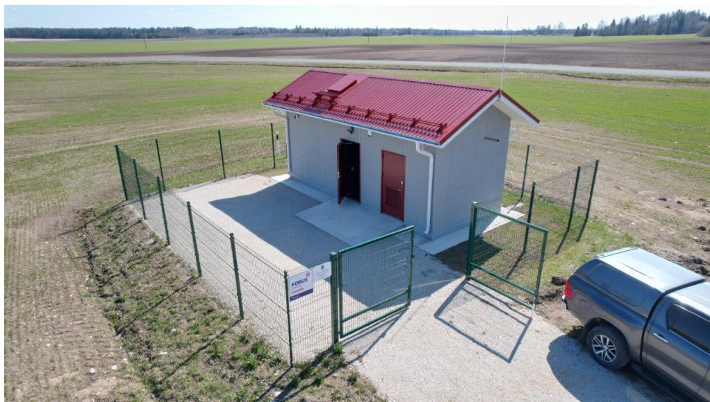
Joonis 4-21 Levala rekonstrueeritud puurkaevpumpla välisvaade (droonifoto, Janek Seidelberg, 05.05.2022)
