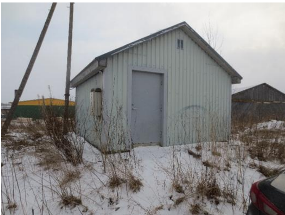
Joonis 4-20 Lasila puurkaevpumpla nr 2783 välisvaade (nagu pildilt näha, ei ole mõeldav puurkaevule tagada nõutavat sanitaarkaitseala)
