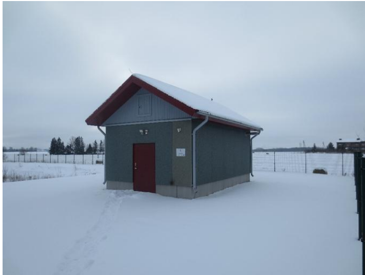
Joonis 5-14 Arkna reoveepuhasti välisvaade (vasakul on näha tühjendatud biotiiki)
