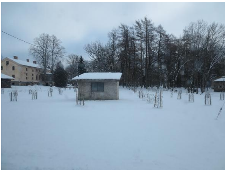
Joonis 4-16 Arkna kavandatava reserpuurkaevpumpla nr 3096 välisvaade
