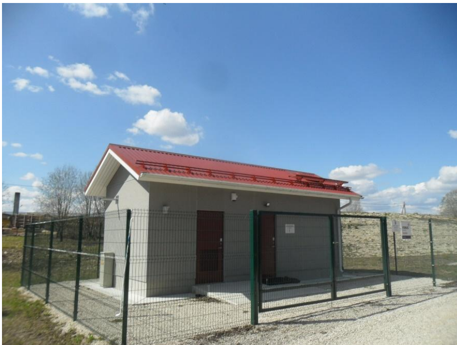
Joonis 4-19 Lasila puurkaevpumpla nr 62174 välisvaade (pumpla on klassikaline AS Rakvere Vesi viimase 10 aasta väikeste pumplahoonete projekt, vasak uks avaneb avariigeneraatoriruumi)
