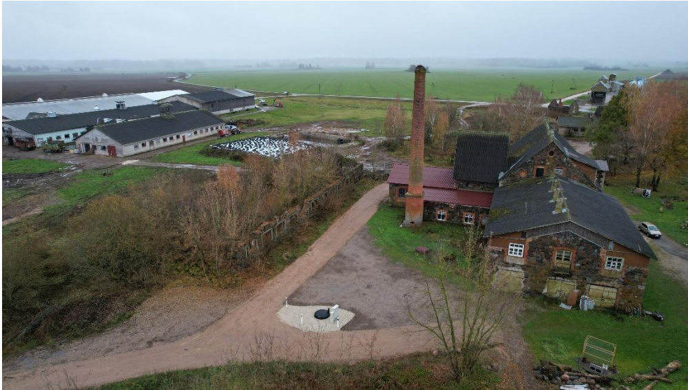
Joonis 5-11 Vaeküla reovee peapumpla, Viinavabriku pumpla
