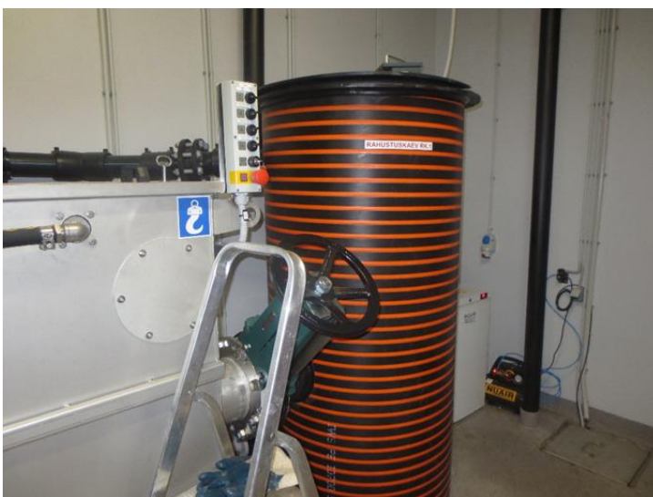
Joonis 5-8 Reoveepuhasti sisevaade (esiplaanil osa automaativõreseedmest ja voolurahustusmahuti)
